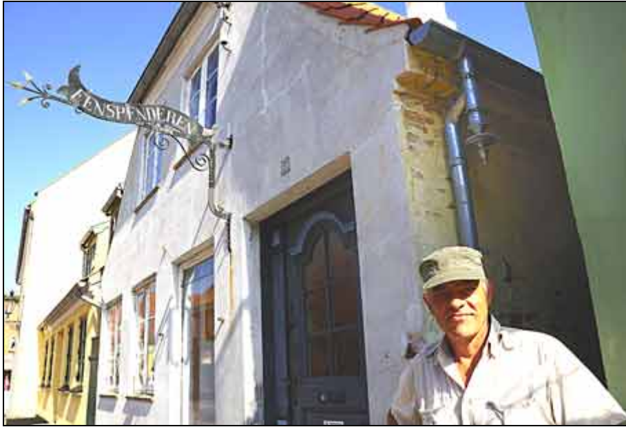
Bjarne Ørbekker foran sit hus i Søndergade, Ærøskøbing, hvor et zink-drueknæ indgår som en naturlig del af blikkenslagerarbejdet.
