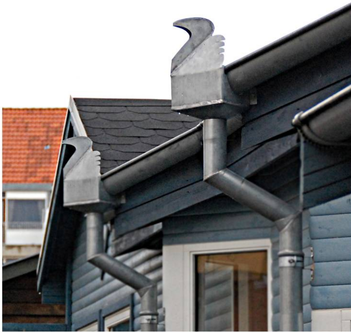
▲ Vandsamlere og nedløb ført ned langs vindue
